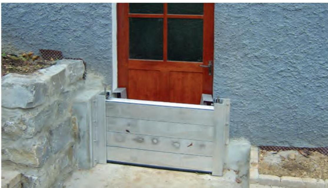
Abbildung 17 Beispiel mobiles Schutzsystem an Gebäudeöffnungen, Quelle Hochwasserschutzfibel, Bundesministerium des Inneren, für Bau und Heimat
